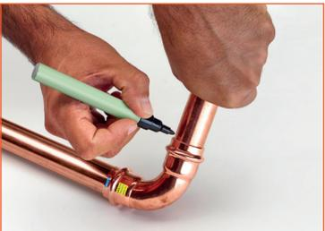
4) **Führen Sie das Rohr** in dem Fitting bis zum Anschlag ein. Üben Sie dabei eine leichte Drehung auf das Rohr aus. Danach markieren Sie die Einstecktiefe des Rohrs mittels eines Markers, um eventuelle Bewegungen des Rohres vor des Pressens zu erkennen.
