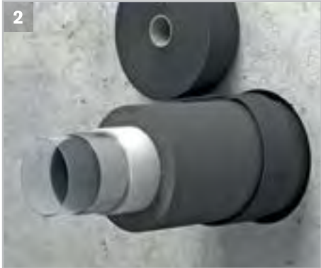
Anschließend das Brandschutzband mit 50 mm Breite um die Isolierung legen.
