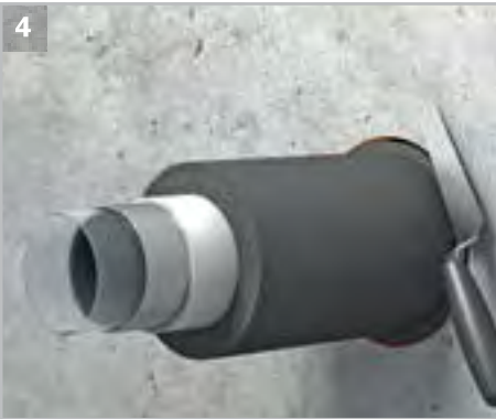
Bei der Variante „selbstklebend“ muss die Schutzfolie abgezogen werden. Danach kann das Band angedrückt werden. Ansonsten wird das Band mit Klebeband fixiert.
