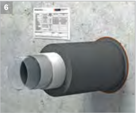
Zum Schluss muss das Kennzeichnungsschild angebracht werden.
