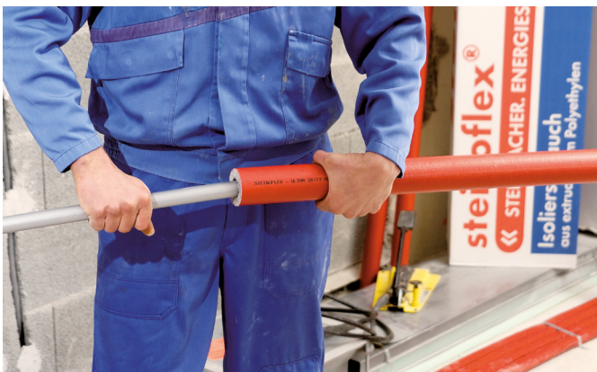
optimal für mechanisch stark beanspruchte Rohrleitungen; mit widerstandsfähiger Schutzfolie
