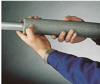
Bei waagrecht verlegten Leitungen Längsnaht nach unten (6:00 Uhr) drehen, an Bögen vorzugsweise auf deren Innenseite. Es ist darauf zu achten, dass die verklebten Längsstoßflächen nicht überhöhten Dauerzugspannungen ausgesetzt sind, da dies die Kleberdauerhaftung negativ beeinflussen kann. Problemstellen (Muffen, Abzweiger, Bögen, etc.) und nachträglich unzugängliche Leitungen sind daher mit **steinoflex®** Klammern und Spezial-Klebeband zu sichern.
