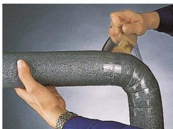
Ist ein Aufschieben am Bogen nur erschwert oder nicht mehr möglich, ist der Bogenbereich separat zu isolieren. Die einzupassende Bogendämmung ist mit Segment- bzw. Gehrungsschnitten auszuführen.
