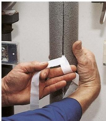
Die Abdeckbänder werden von der Schlauch-Längsnaht abgezogen. Danach wird der Längsstoß zusammengepresst. Der Spezial-Klebstoff sichert die einwandfreie Kleberhaftung bis zu einer Mediumrohrtemperatur von max. +85 °C.
