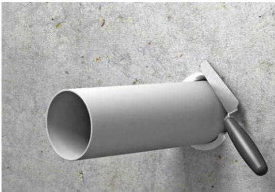
2. Manschette um das Rohr legen und verschließen – in Wänden beidseitig, in Decken unterseitig. Die jeweils kleinste passende Manschette verwenden:\*
