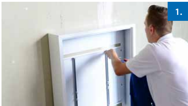
Schritt 1: Verteilerschrank setzen
