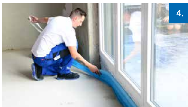
Schritt 4: Randdämmstreifen setzen
