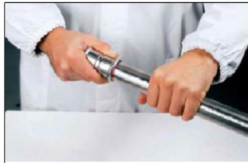
Einführen des Rohres in den Pressfitting
