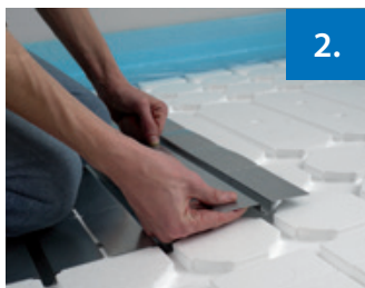
Abbildung 2: Verlegung der Wärmeleitbleche
