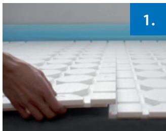
Abbildung 1: Plattenverlegung
