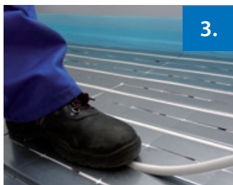
Abbildung 3: Heizrohrverlegung
