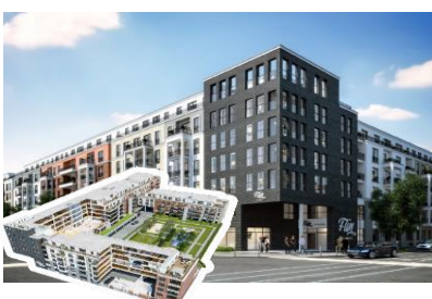
Objekt: 184 Wohneinheiten „Flin Carree“ in Düsseldorf
