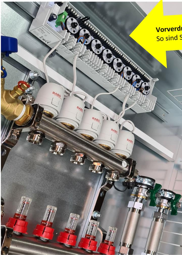
Vorverdrahtet incl. **Basis Switch mit Drehschalter**
