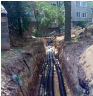
Idealerweise wird der Aushub auf einer Seite der Trasse zwischengelagert. Von der freien Seite aus werden die folgenden Schritte ausgeführt:
