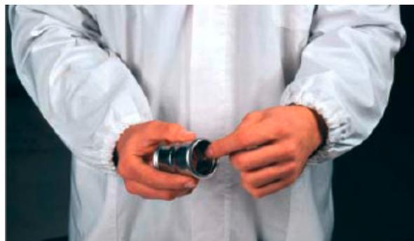
Überprüfung des Dichtrings
