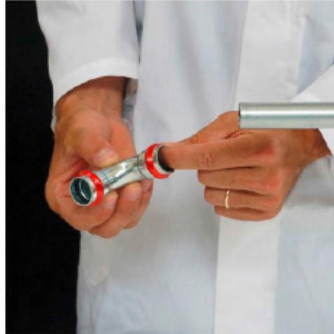
Überprüfung des Dichtrings
